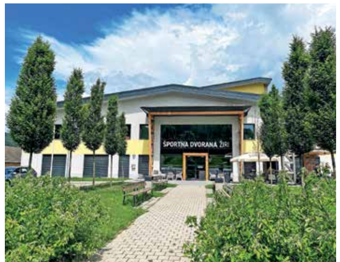
Postavitev sončne elektrarne načrtujejo tudi na strehi športne dvorane. Foto: Tanja Mlinar
